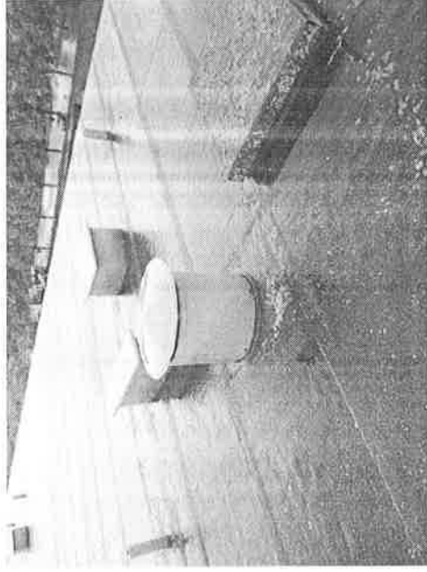
Ventilationshætter fra både lejligheder samt fra nedfaldsskåle
