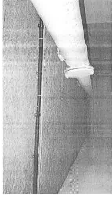
Træbetonloft i kælder.
